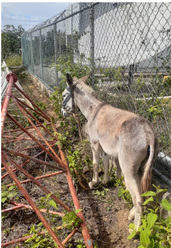
Figura 4. Estación de Telecomunicaciones de la UDO
